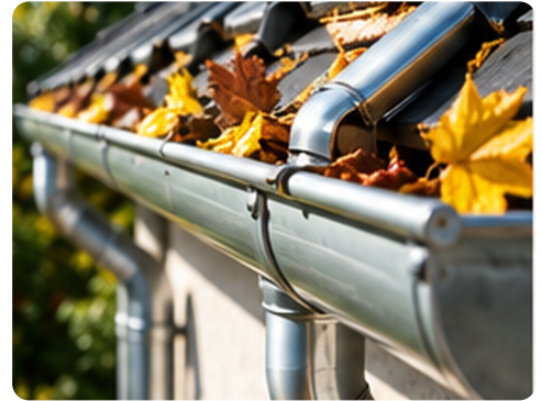
Gouttière, chéneau et descente : contrôler l'écoulement, les fixations, les raccords et l'absence d'obstruction.
