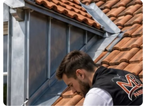
Points de contrôle visibles sur une toiture inclinée.
